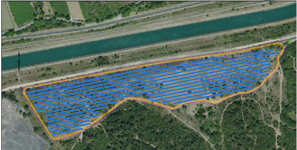
Zone d’emprise du projet – Octobre 2018
