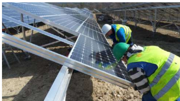
Montage des modules
