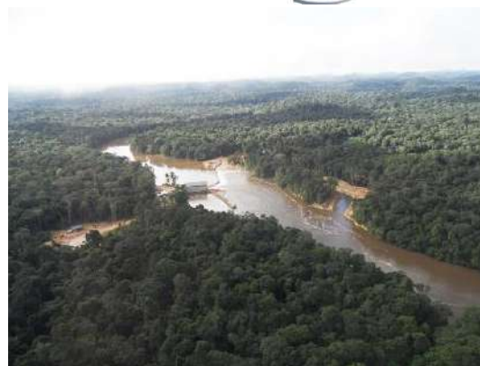
Centrale hydroélectrique– Source : VOLTALIA
