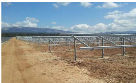
Montage des structures
