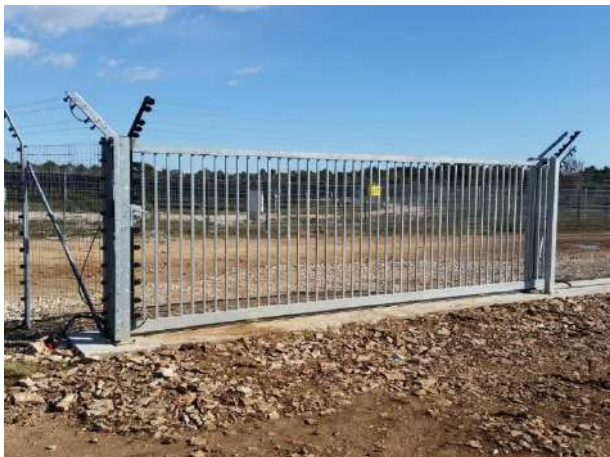
Exemple de portail coulissant- Parc solaire de Castellet - VOLTALIA
