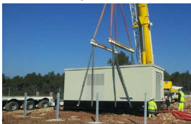
Installation des postes de transformation
