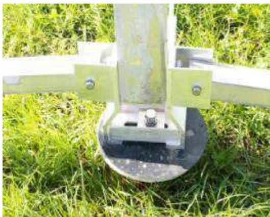
Platine d'une vis d'ancrage
