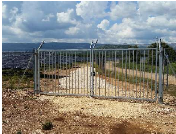
Exemple de portail à battant- Parc solaire de Castellet - VOLTALIA
