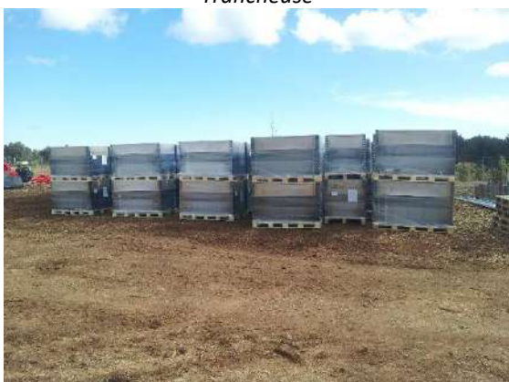
Stockage des modules
