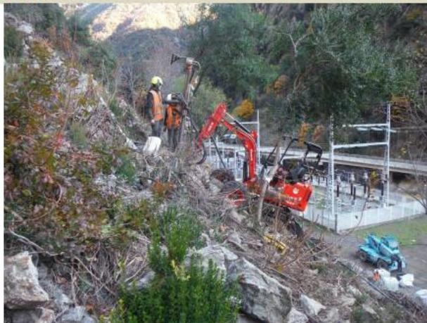
Photo 1 – EPB5. Forage ancrage amont en cours
