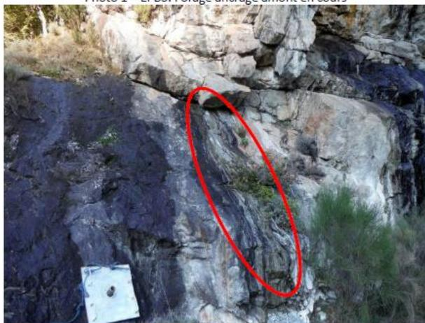
Photo 3 – EPB4. Exsurgence de coulis par la fracture ouverte au pied du grand compartiment (communication avec le forage du latéral sup. au rocher)
