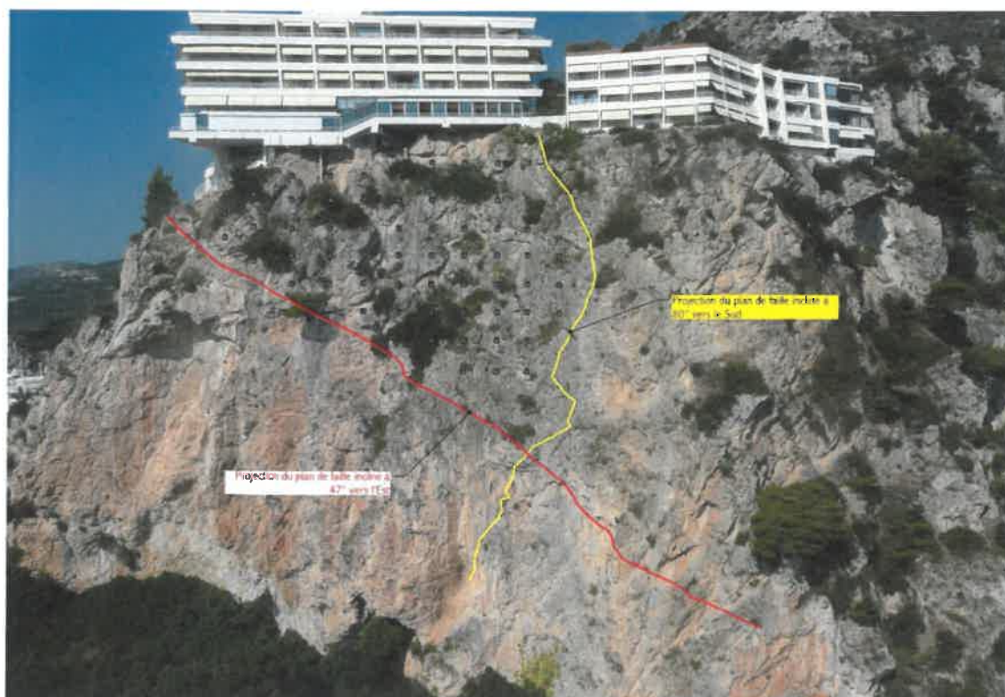
Localisation des failles du dièdre rocheux à sécuriser pour la mise en œuvre du Permis de construire (2 nd phase de travaux : En cours)
