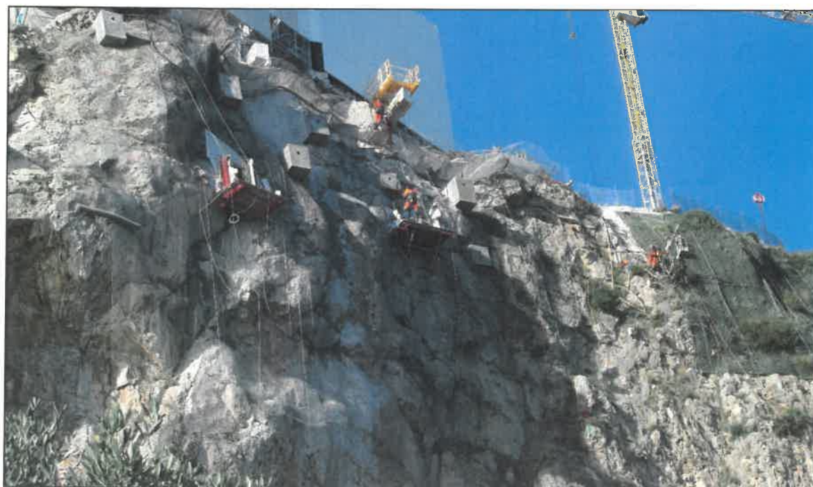
Mise en place des coffrages de béton pour les têtes de tirants B.TEUF, 13/02/2019, Roquebrune-Cap-Martin (06)
