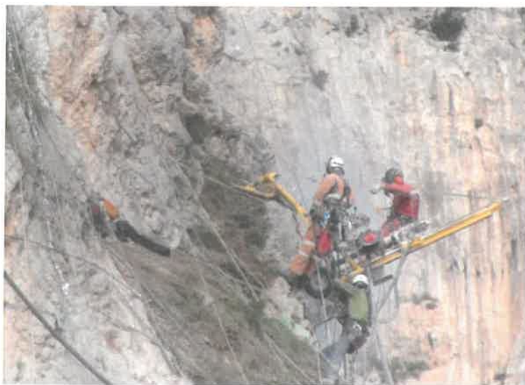
Travaux sur corde en falaise
