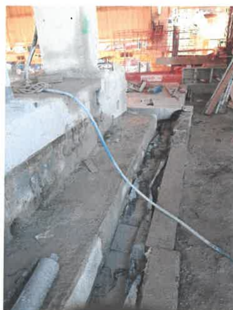
Système de rigole en pente douce au niveau de l'Aéro, acheminant les eaux de chantier à l'opposé de la falaise
