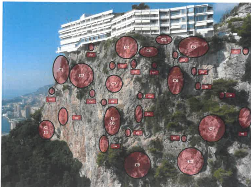
Vue frontale de la falaise sous Aéro – masses instables à sécuriser (1 ère phase de travaux : achevée)
