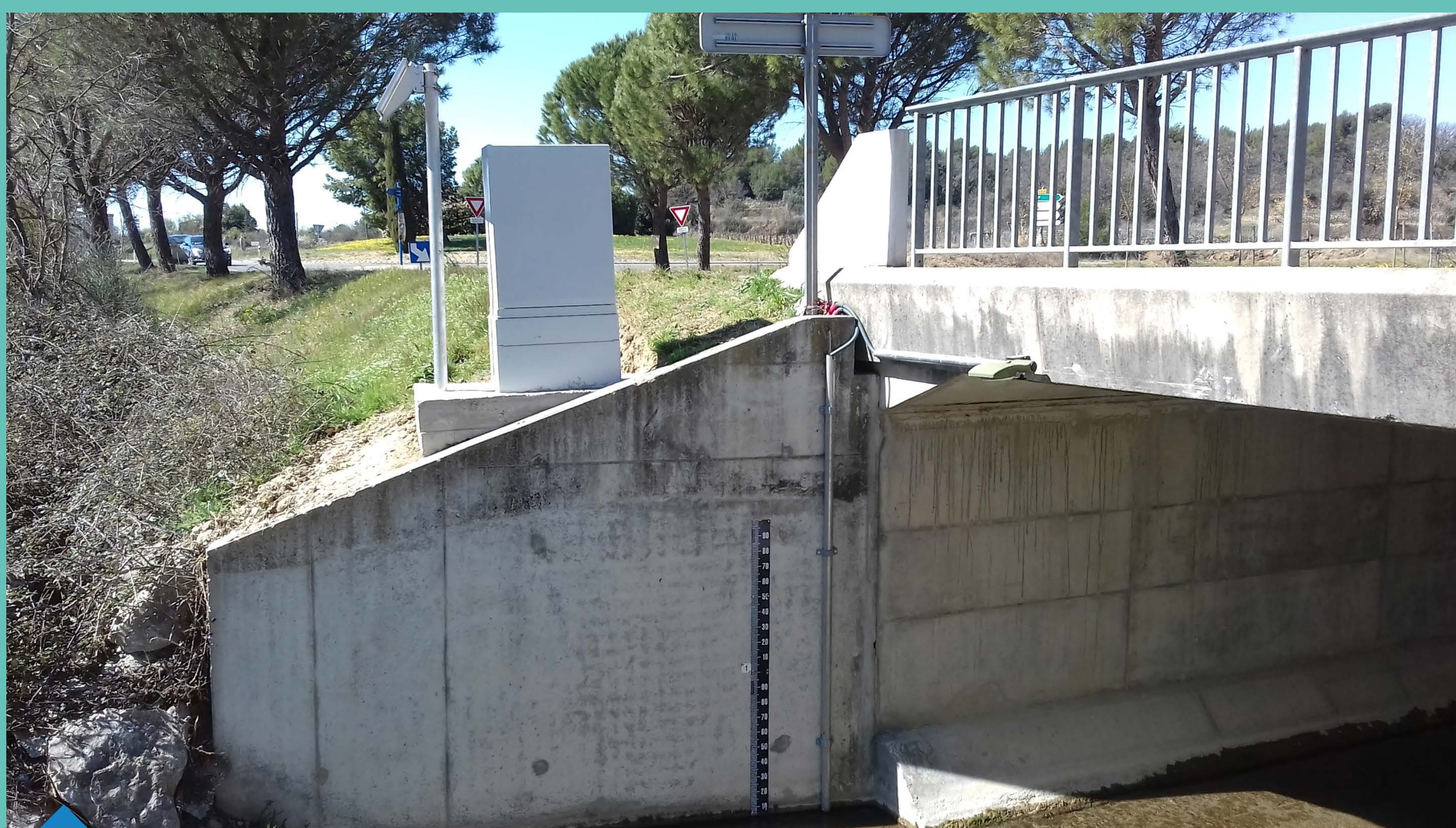
Station de mesure sur la rivière du Brégoux dans le Vaucluse (Source © EPAGE Sud Ouest Mont Ventoux)
