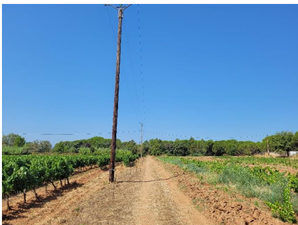
Photo 1 : Pylône à remplacer par un support aérosouterrain. La future liaison souterraine commencera de ce pylône. Photo en direction ouest.
