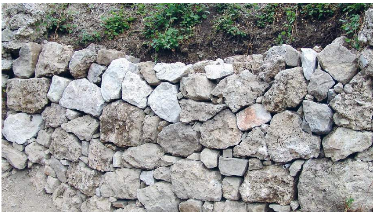
Figure : Exemple de muret de pierre sèche
