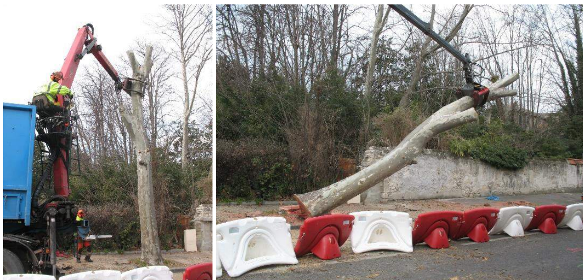
Exemple de dépose délicate d'un tronc creux pouvant abriter des chiroptères
