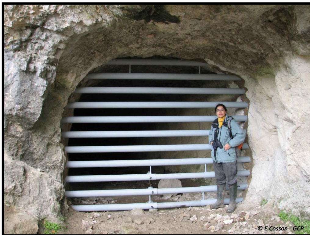
Grille de protection à l'entrée de l'ancien canal du Verdon (04)
