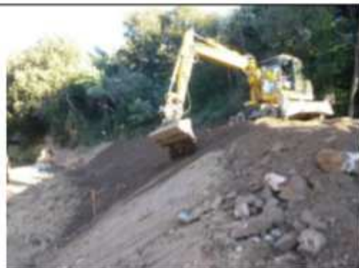
Ré-étalement de terres de surface (Chantier Carimai SIFRO/CACPL par RAZEL-BEC/GUINTOLI)
