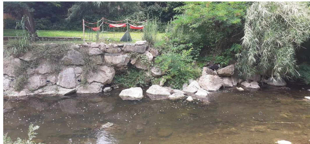
FIGURE 5 : VUE DES DÉSORDRES EN RIVE DROITE
