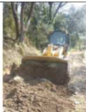
Ré-étalement de terres de surface (Chantier Coudouron SIFRO/CACPL par RAZEL-BEC)
