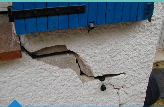
Fissure extérieure d'un soubassement (Source © BRGM - P. Burchi)
