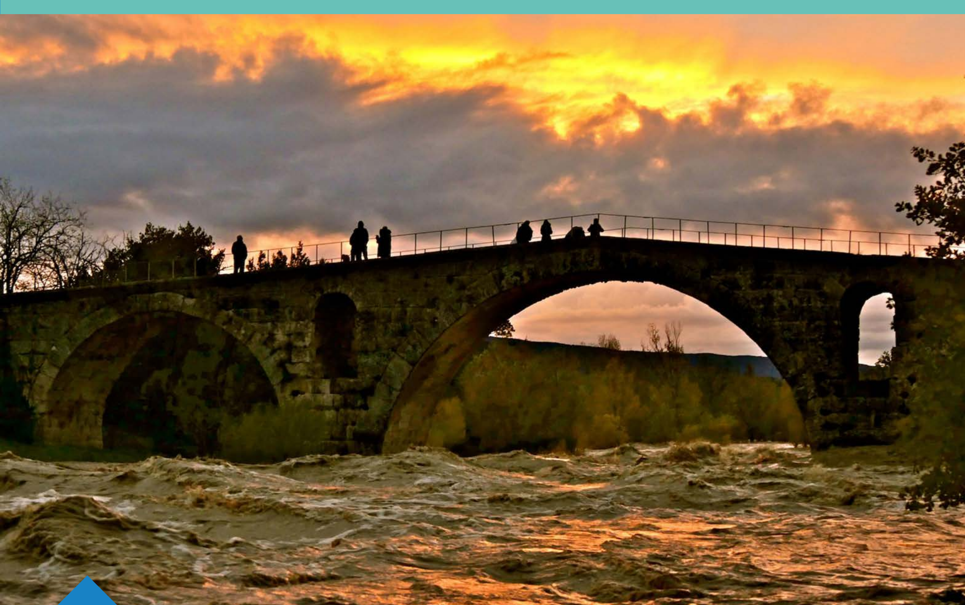
Crue Calavon novembre 2019 – pont JULIEN commune de Bonnieux (Source © Serge TRUPHEMUS, photographe club photo de Saignon)
