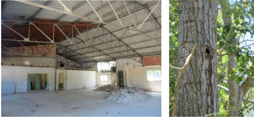
Figure 19. Bâtiment désaffecté inspecté (non favorable) et arbres à cavités
