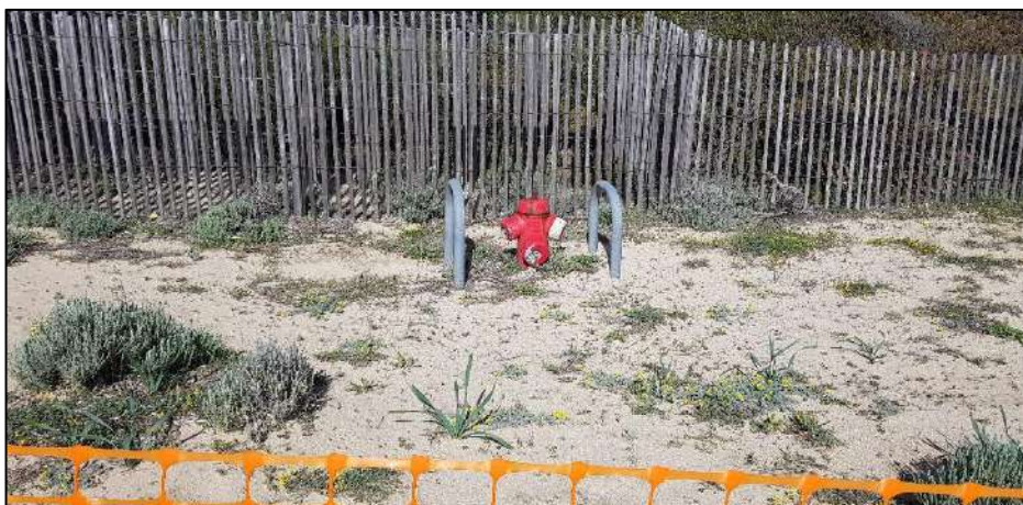
Vue du poteau à déposer Seul le poteau sera déposé, la conduite l'alimentant sera laissée en place (Avril 2019)
