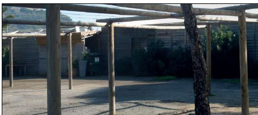
Le dos des bâtiments constitue un obstacle à l'accès au domaine public maritime
