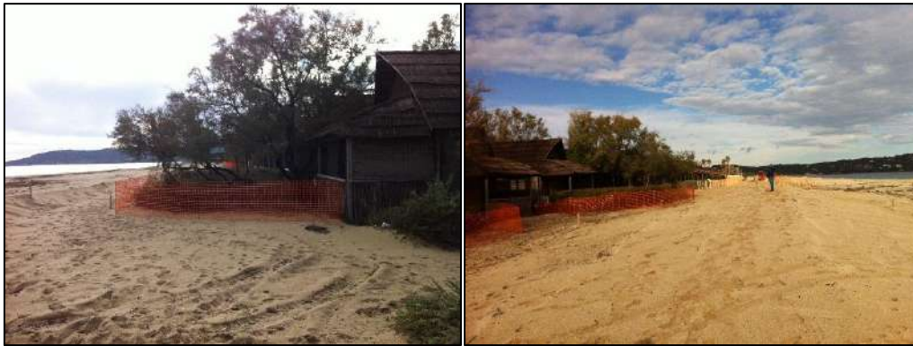
Exemple de balisage en place lors de la phase 2 des travaux (décembre 2019) (Secteur Campings)
