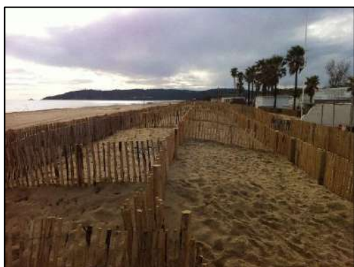
Ganivelles mises en œuvre pour la reconstitution d'un cordon dunaire / Information du public
