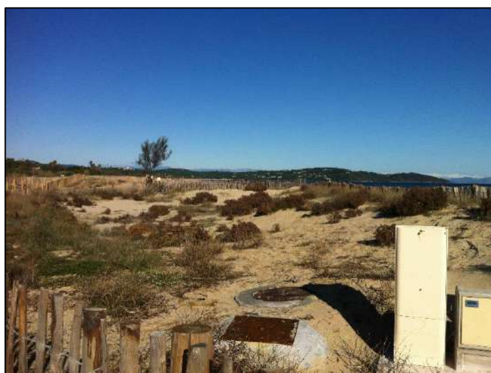
Vue de la zone impactée par le Lot 23 (29/11/2019)
