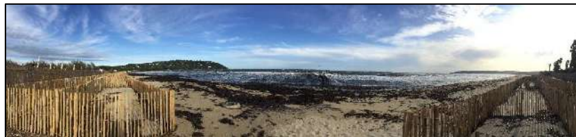
Ganivelles mises en œuvre pour la reconstitution d'un cordon dunaire
