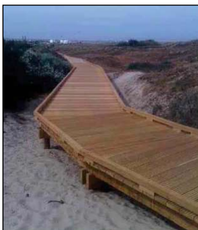
Cheminement sur structure bois surélevée
