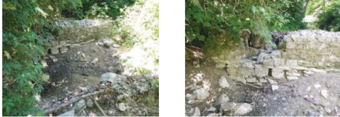
Photographies de l'ouvrage prise au cours de la prospection
