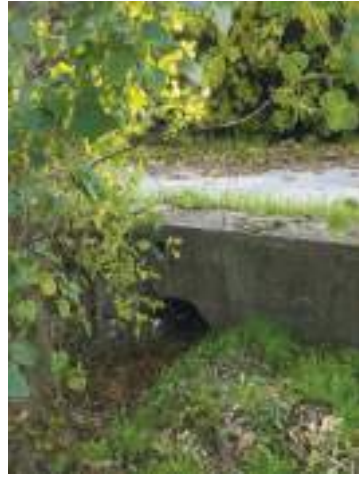
Photographies de l'ouvrage prise au cours de la prospection
