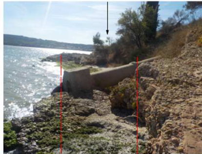
Détail démolition partielle de la buse Ø 1000
