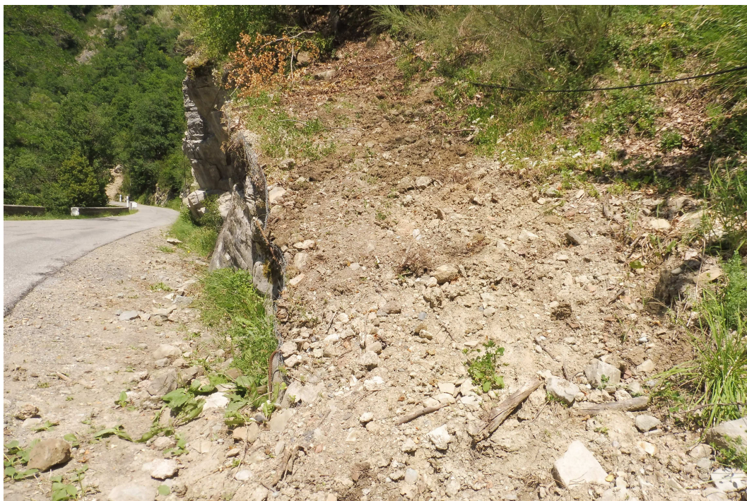
Site RNN de LA Colle : mise en place d'une nouvelle protection de surface, suite au chantier de purge de la MT de Digne-les-Bains.
