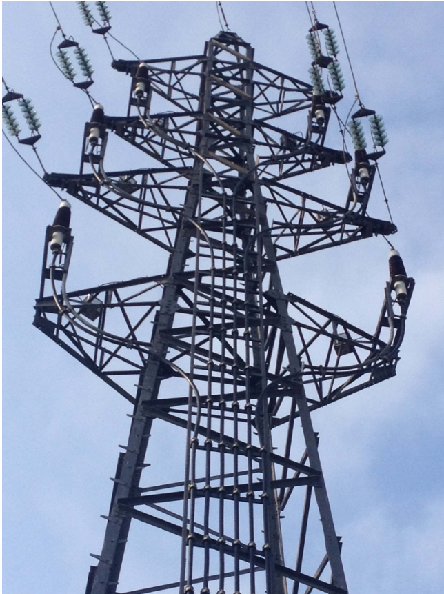
Exemple de support aéro-souterrain 225 000 volts
