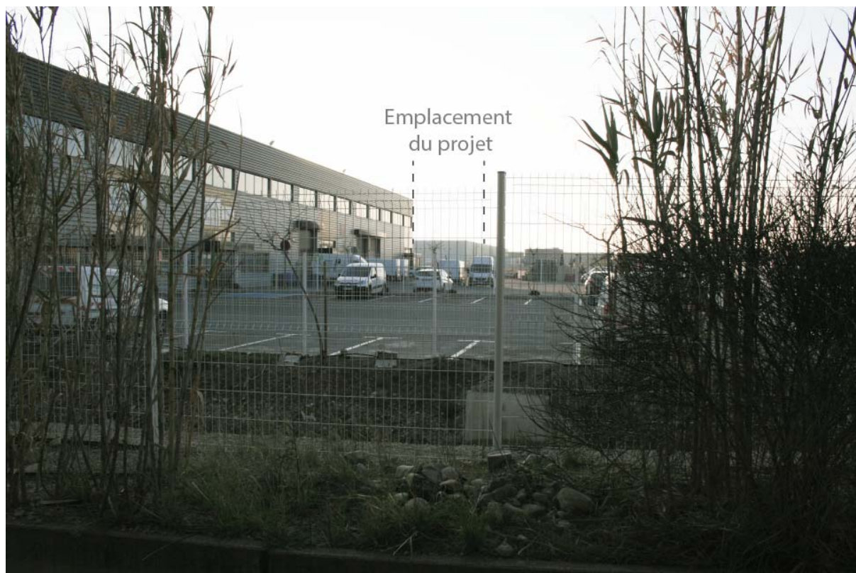
Photo 4 : Emplacement du projet vu depuis les maisons les plus proches.
