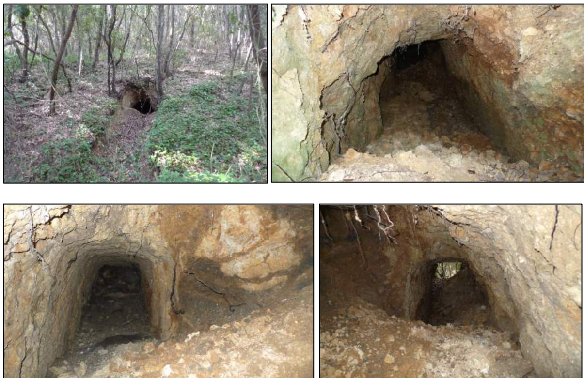
VALMASQUE - Galerie pénétrable G1 dans des terrains sablo-gréseux boullants
