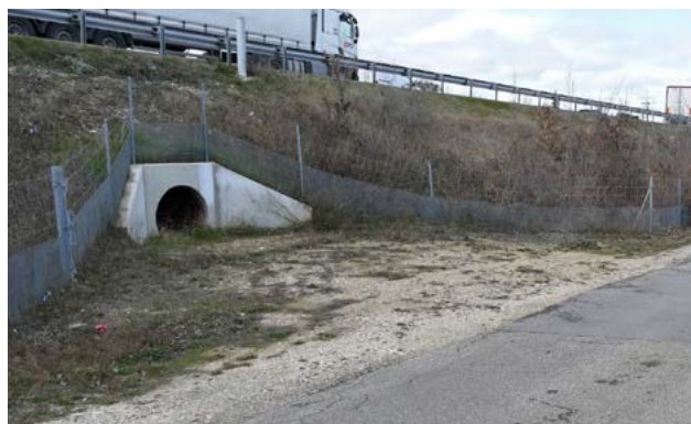
Grillage au niveau d'un écoduc sous l'A7 © Nicolas FUENTO
