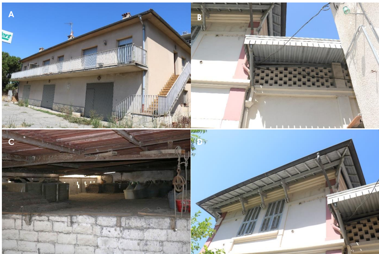
Figure 17 : A – Bâtiment Nord ; B – Bâtiment Est avec ouvertures ; C – Combles occupées ; D – Avancées de toit (source : Ecotonia)
