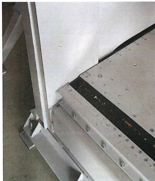
DETAIL JOINT SUR BASE
