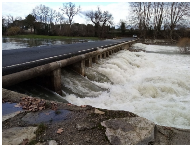
Vue en crue, le 26-01-2020 15h-Source SPC GD
