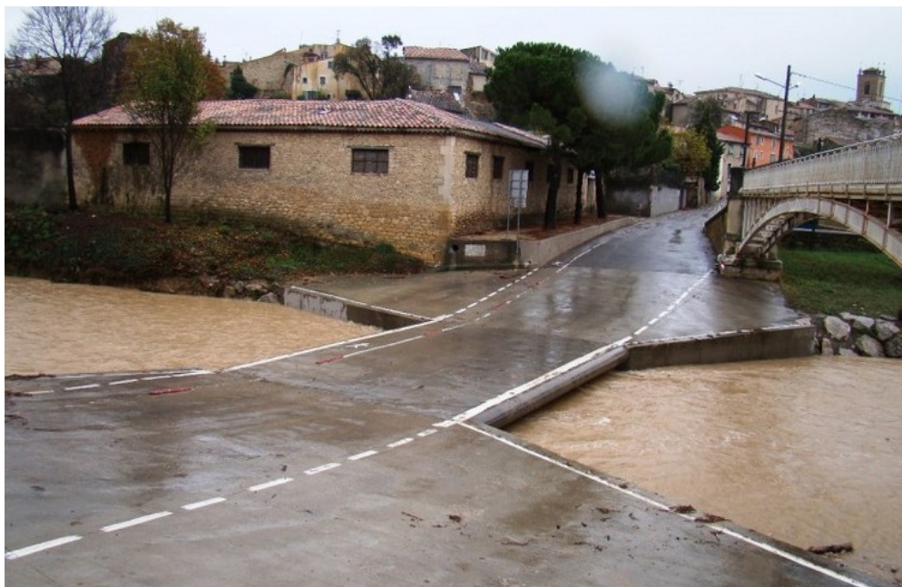
Illustration 4: Pont submersible – Photo : site de la ville Pertuis- Source : Cerema Méditerranée
