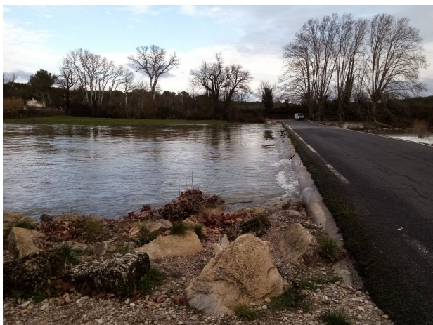
Vue en crue, le 26-01-2020 15h-Source SPC GD
