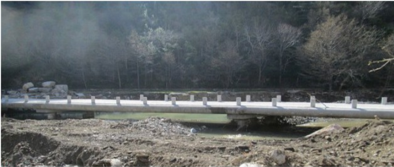
Illustration 5: pont submersible d'Avene (34), après la crue de 2014 ; l'ouvrage a tenu, mais a été contourné (Source : Les gués et ponts submersibles, lieux familiers, lieux de danger CGEDD septembre 2015)
