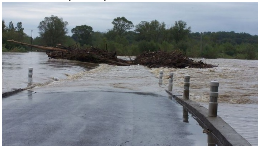
Vue en crue (2008)
