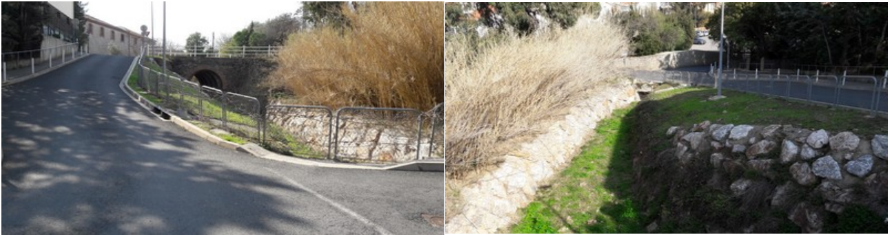
Illustration 6 : Place du Marché – en amont (à gauche) le dimensionnement du ravin est important ; en aval (à droite) il se réduit et occasionne des débordements, inondant le centre-ville
