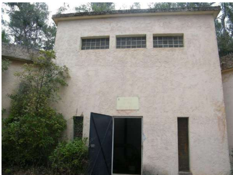
Figure 1 : Photographie de l'entrée du réservoir de Tasseau (Source SDAEP G2C)
