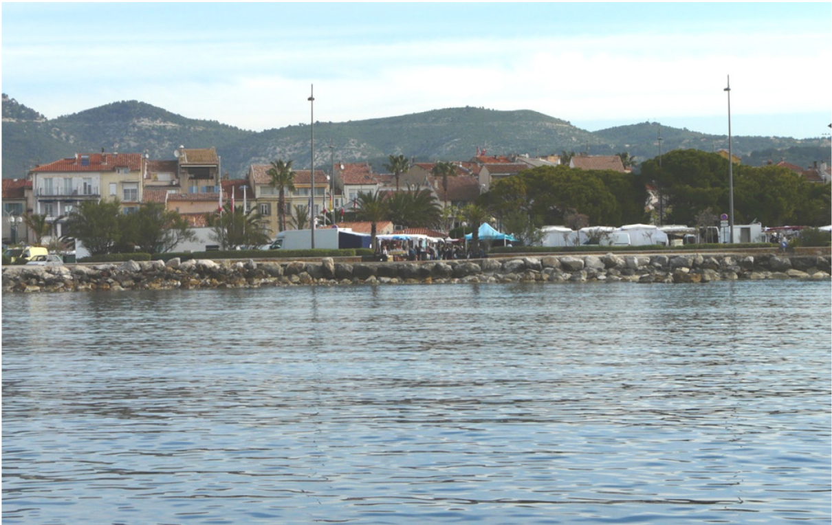
Photo 1 : Vue des enrochements de protection de l'Esplanade depuis la mer (22/04/2015). Voir carte 1.
