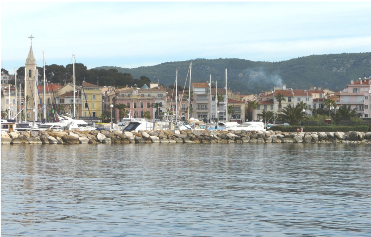
Photo 2 : Vue de la digue du Levant depuis la mer (22/04/2015). Voir carte 1.
