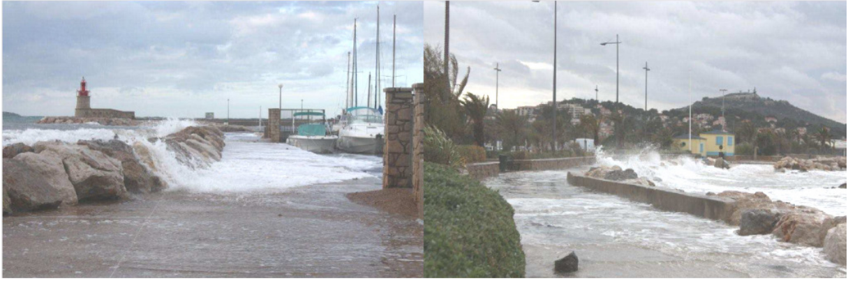
Photo 5 : Franchissement des ouvrages en cas de fortes houles ("largade" du 30/11/2008).
