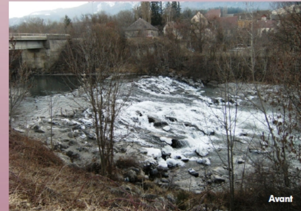
Ouvrage sur le Drac - Saint-Bonnet (Hautes-Alpes)
