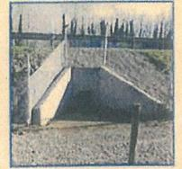
Les écoducs ou passages à petite et moyenne largeur seront réalisés par le placement de tuyaux dans les remblais des infrastructures sous forme de petits tunnels. Les conditions de réalisation maîtrisées allées à leur fonctionnalité avérée permettent de multiplier ces passages afin d'agir à grande échelle et créer des transectes régulièrement répartis.
