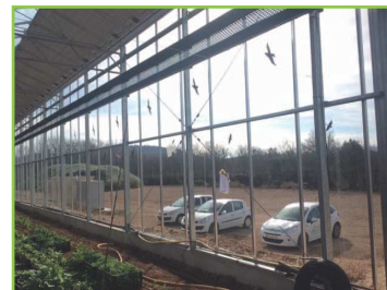
Dispositif effaroucheurs en paroi latérale pour la protection des oiseaux
