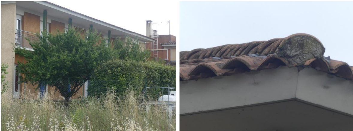
Figure 37 : Photographies des bâtiments sur l'aire d'étude
