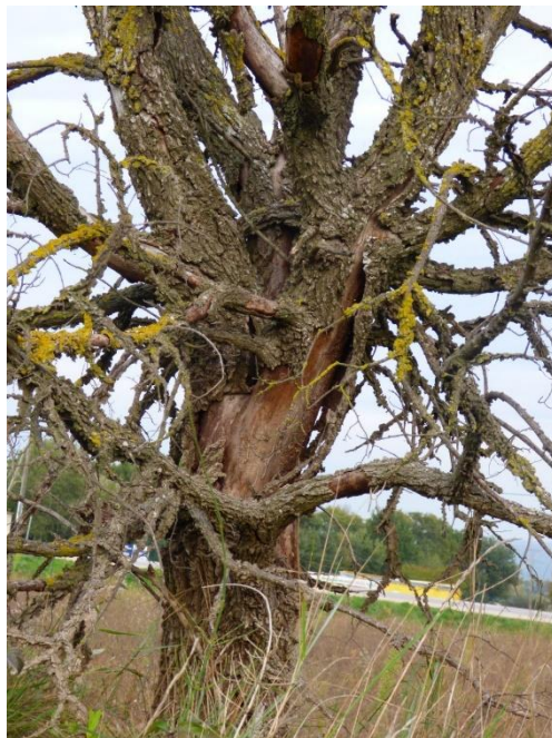
Figure 58: Arbre présentant des décollements d'écorce dans l'aire d'étude
