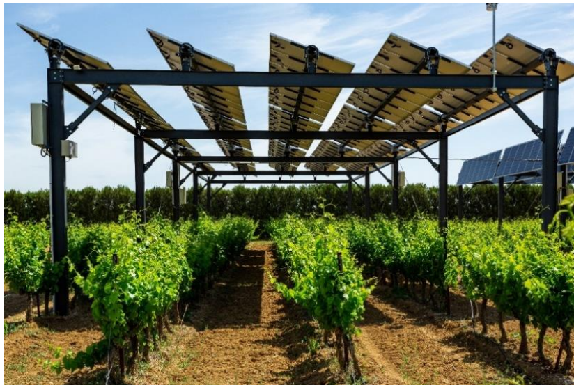
Figure 1: Dispositif expérimental structure AVD plein champ Sun'Agri en vignes (Domaine Expérimental de Piolenc CA84)
