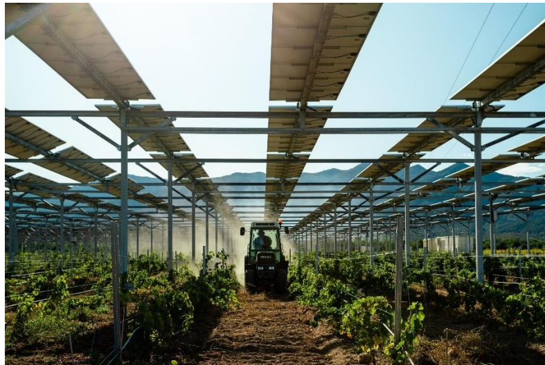
Photo 2 : structure permettant le passage d'engins agricoles
