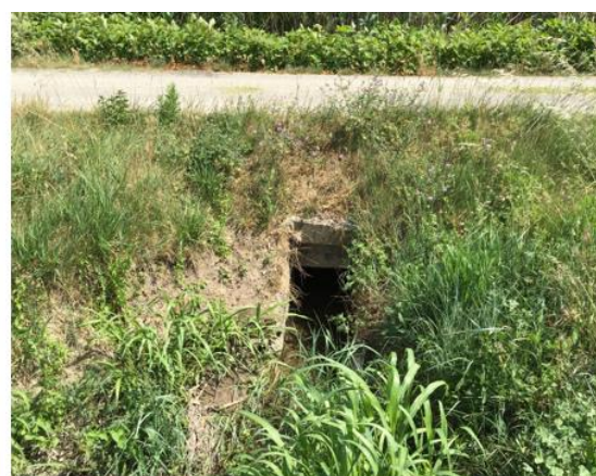
Ouvrage L50 x H 40 cm – prise d'eau de la filiole n°2
