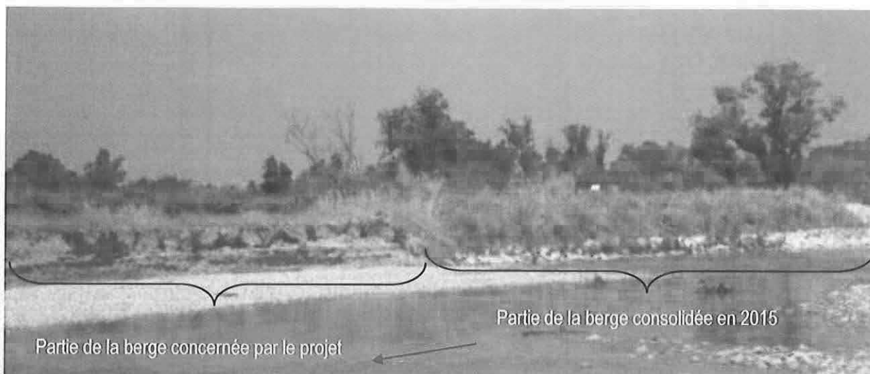
Photo 2 : Vue depuis le lit de l'Aygues de la berge à protéger dans le prolongement des travaux de 2015
