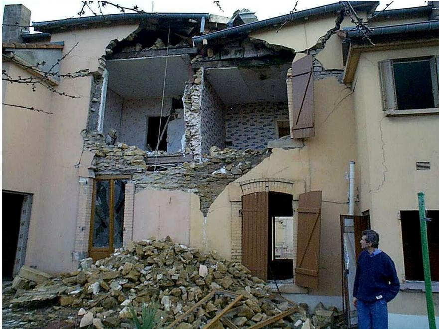
Photo 5 : Conséquences sur le bâti des affaissements d'Auboué (Bassin ferrifère lorrain)
