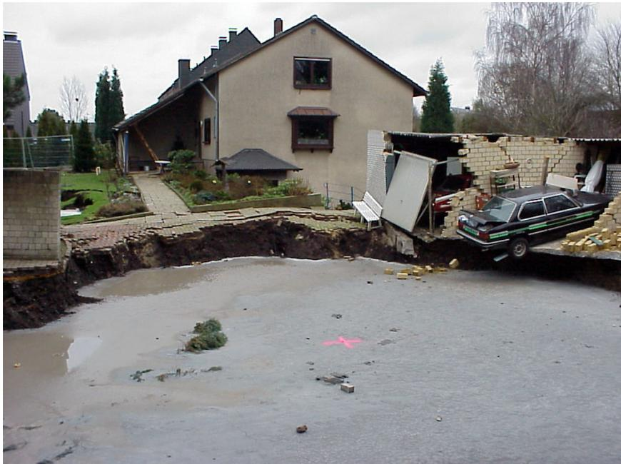
Photo 7 : Effondrement d'une tête de puits en Allemagne.
