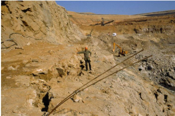
Photo 10 : Glissement d'un compartiment rocheux découpé par deux failles majeures et sous-miné par d'anciens travaux miniers souterrains.
