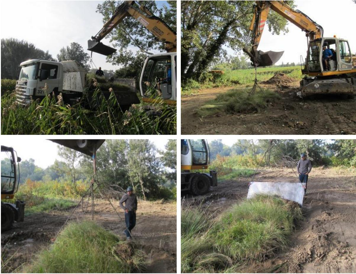
**Figure 29 : Exemple de dépôt de plaque de sol : Pelle mécanique récupérant une plaque métallique ; dépôt au sol ; détachage des chaînes ; glissement de la plaque de sol à terre (photos : NATURALIA).**
