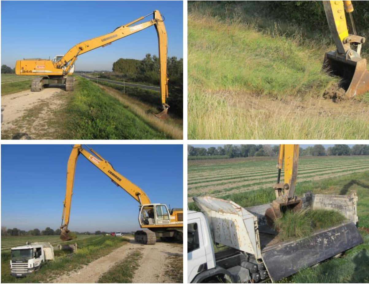
**Figure 28 : Exemple de prélèvement de sol. De gauche à droite, de haut en bas : Pelle mécanique employée pour le prélèvement ; prélèvement de la plaque de sol ; pelle mécanique et camion-benne ; dépôt des plaques de sol sur des plaques métalliques (Photo : NATURALIA).**
