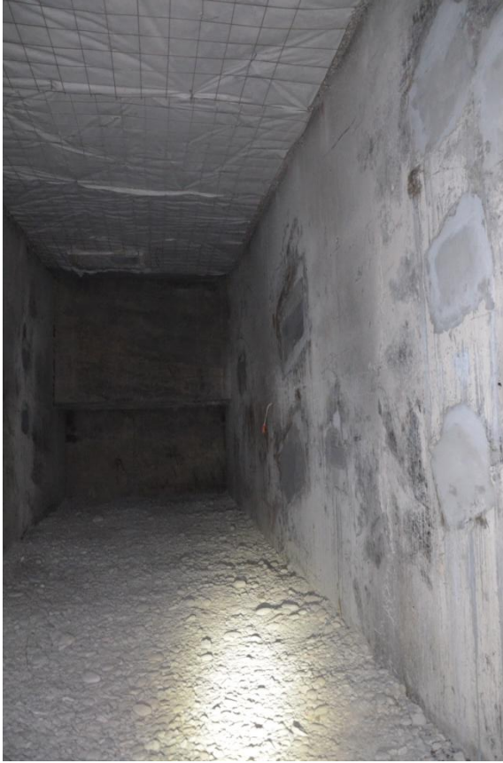
Figure 14 - Vue d'une des deux salles - GCP 2019
