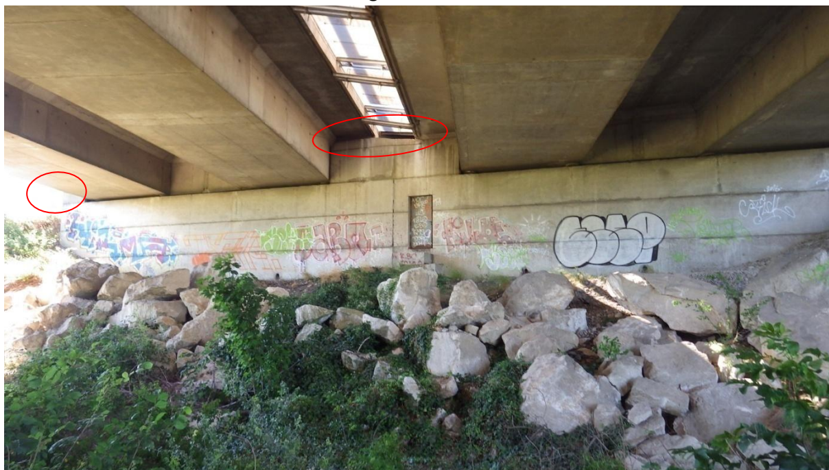
Figure 11 : Porte d'entrée du viaduc, côté sud et localisation de l'accès principal utilisé par les Chiroptères (cercle rouge) – Une sortie secondaire se situe sur le côté amont de la culée Sud. M.GAYAUD, GCP 2016.
