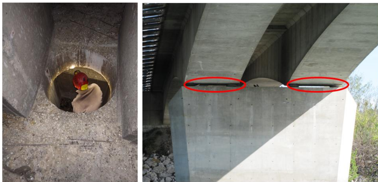
Figure 12 : Ouverture au niveau des piles - F.ALBALAT, GCP 2016
