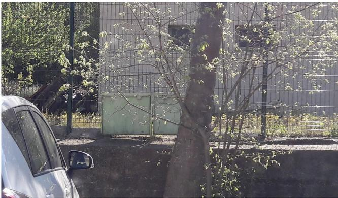
Illustration 1: Des plaques pivotantes ont été installées sur un grillage pour faciliter la vidange du terrain
