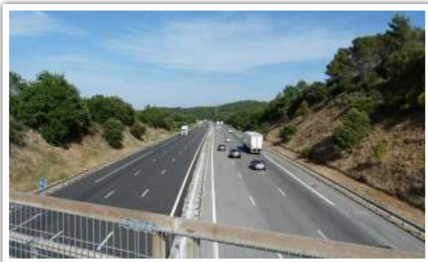
Vue depuis le pont, ouvrage n°38 © Micaël GENDROT
