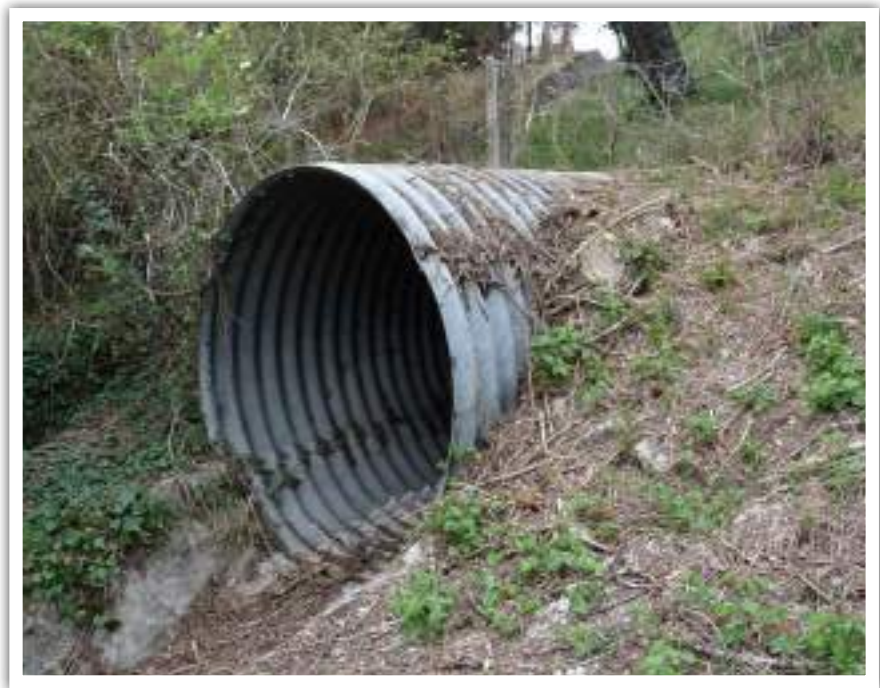
Côté sud de l'ouvrage n° 15 © Micaël GENDROT
