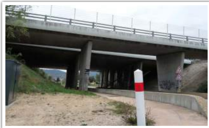
Vue du double viaduc de l'A8 au dessus de la RD554 © Micaël GENDROT
