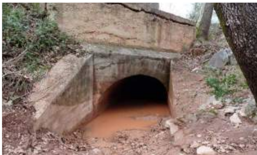
Ouvrage n°6, vu côté sud la RD79 © Micaël GENDROT
