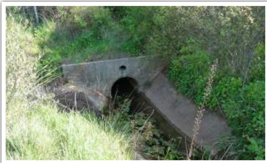
Buse au niveau du talus ouest. Une nappe d'eau stagne, permettant le développement de végétaux aquatiques © Micaël GENDROT
