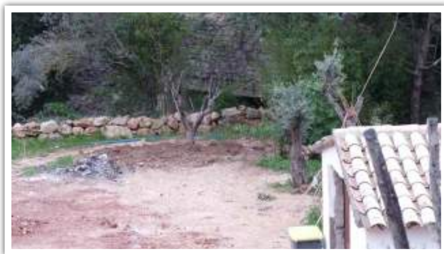
Débouché de l'ouvrage n°9 côté nord © Micaël GENDROT
