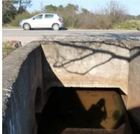
Passage d'un fossé sous la RD33 © Micaël GENDROT
