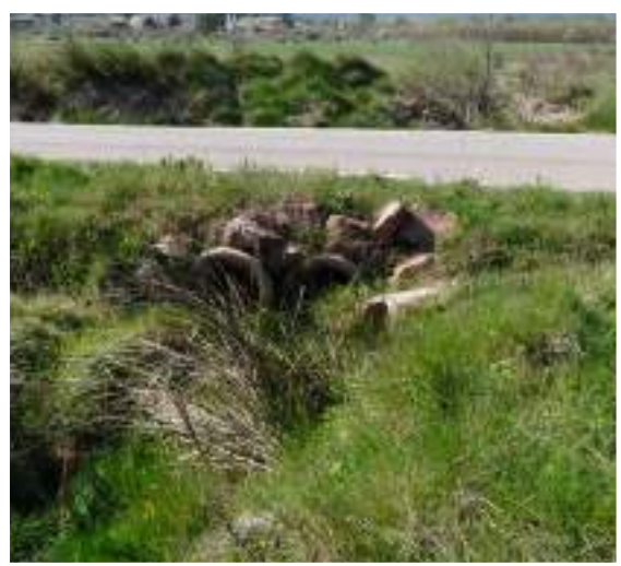
Double buse de l'ouvrage n°9 © Micaël GENDROT
