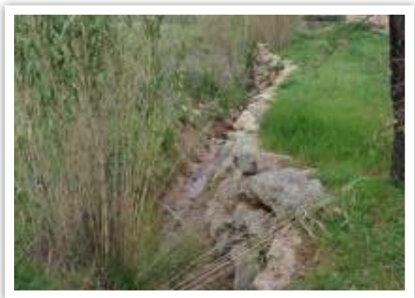
A l'aval de la buse de l'ouvrage n°2 © Micaël GENDROT
