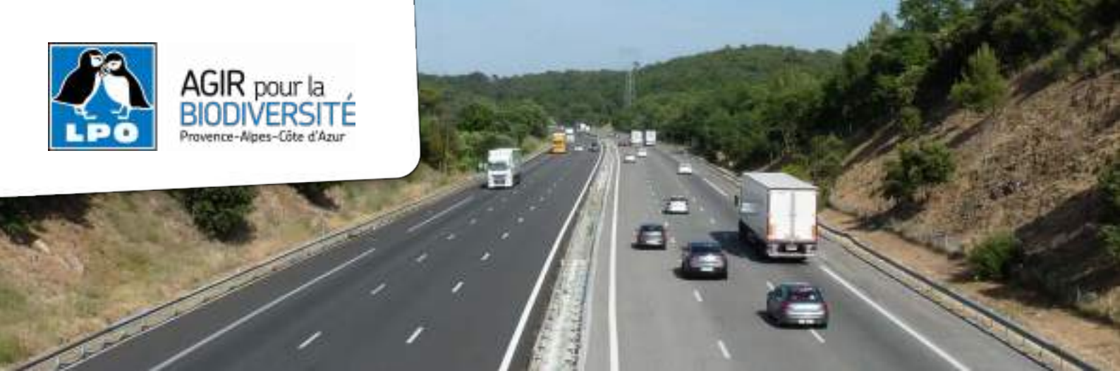
A8 A8 vue depuis le pont, ouvrage n°38 © Micaël GENDROT
