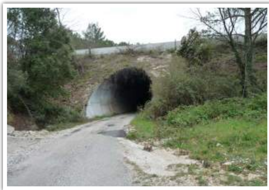
Passage routier de l'ouvrage n°17 © Micaël GENDROT
