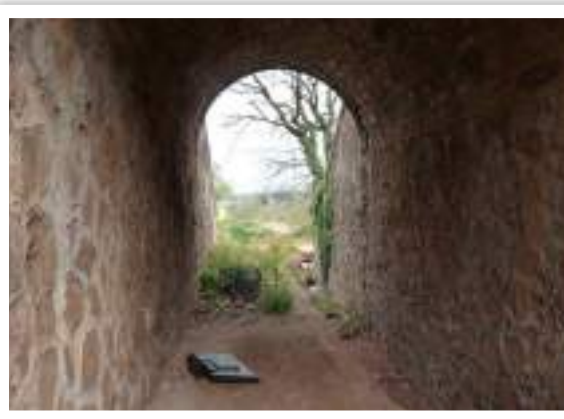
Ouvrage n°25. L'écoulement des eaux se fait dans le fossé côté droit de l'image © Micaël GENDROT
