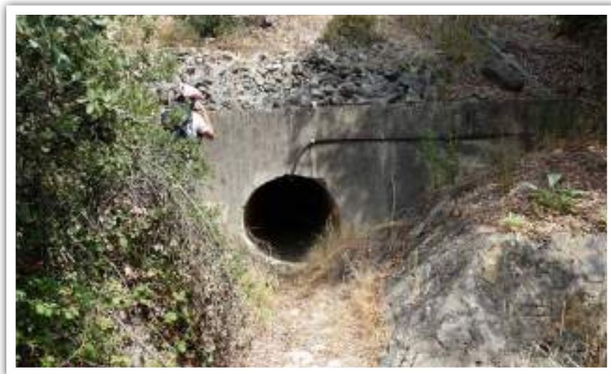
Côté sud de la buse © Micaël GENDROT
