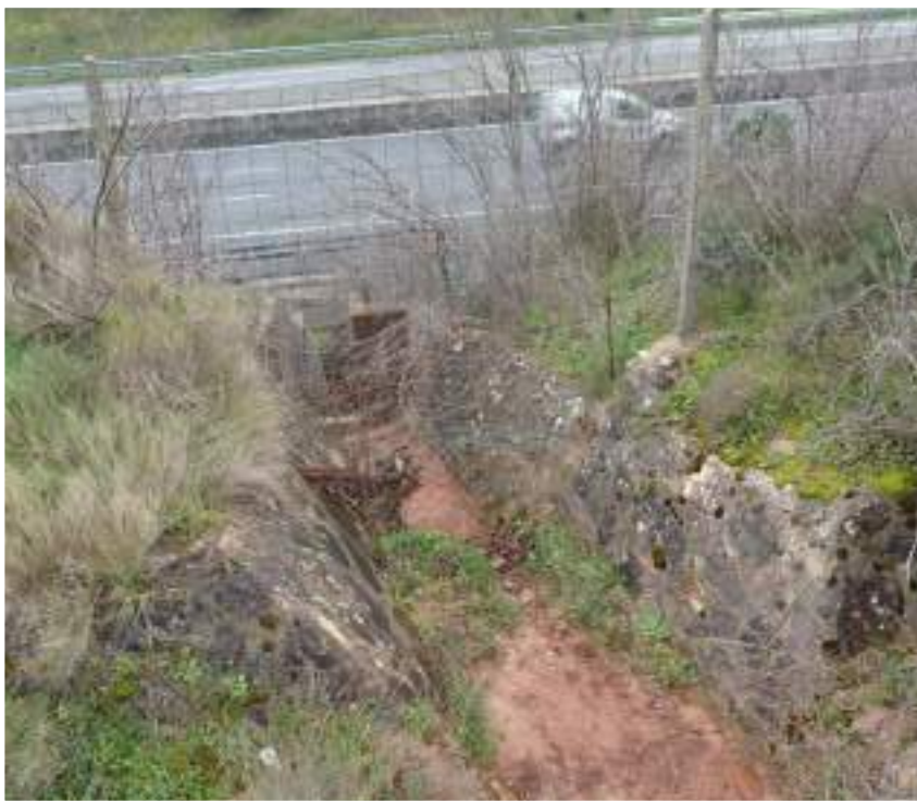
Descente d'eau en amont de l'ouvrage © Micaël GENDROT
