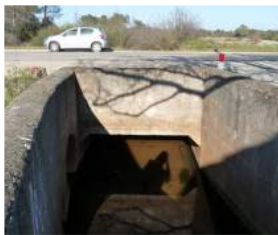
Ouvrage n°1 côté sud © Micaël GENDROT
