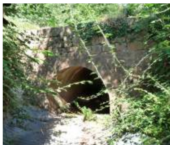
Aval de l'ouvrage n°13 et vue sur l'ancien pont © Micaël GENDROT
