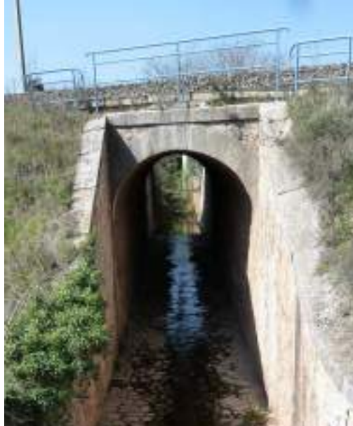
Ouvrage n°11 sous la voie ferrée © Micaël GENDROT
