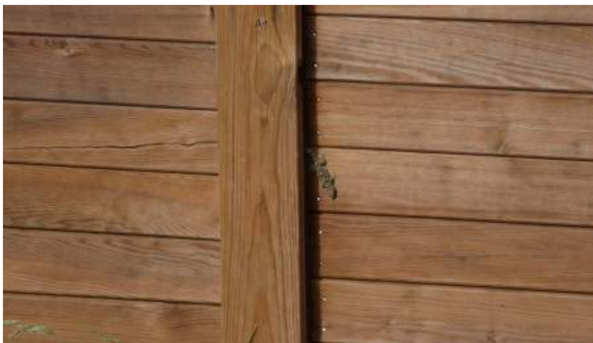
Détail d'un écran acoustique. Les Tarentes de Maurétanie affectionnent les joints de ce mur anti-bruit © Micaël GENDROT
