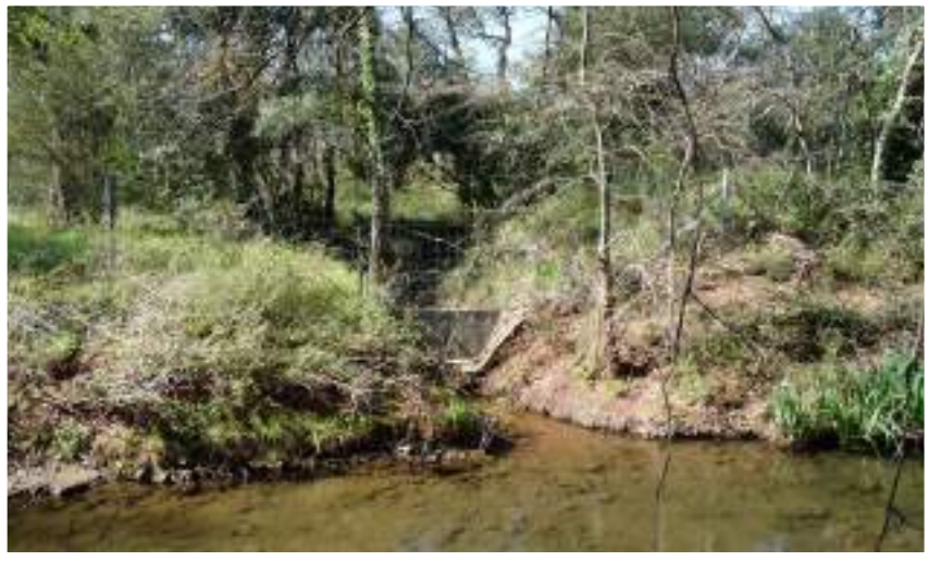
Débouché de l'ouvrage n°10 au niveau du cours d'eau du Riau Tort © Micaël GENDROT
