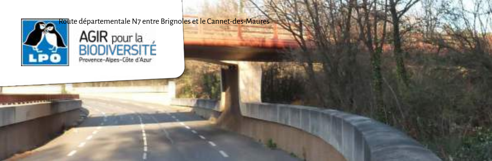
Pont de la RDN7 au-dessus de la RD24 et du Caramy © Micaël GENDROT
