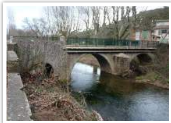
Le pont de la RD33 © Micaël GENDROT
