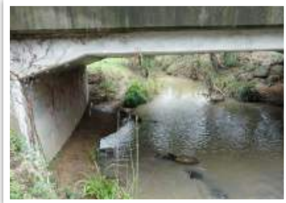
Zoom sur l'ouvrage n°4 © Micaël GENDROT
