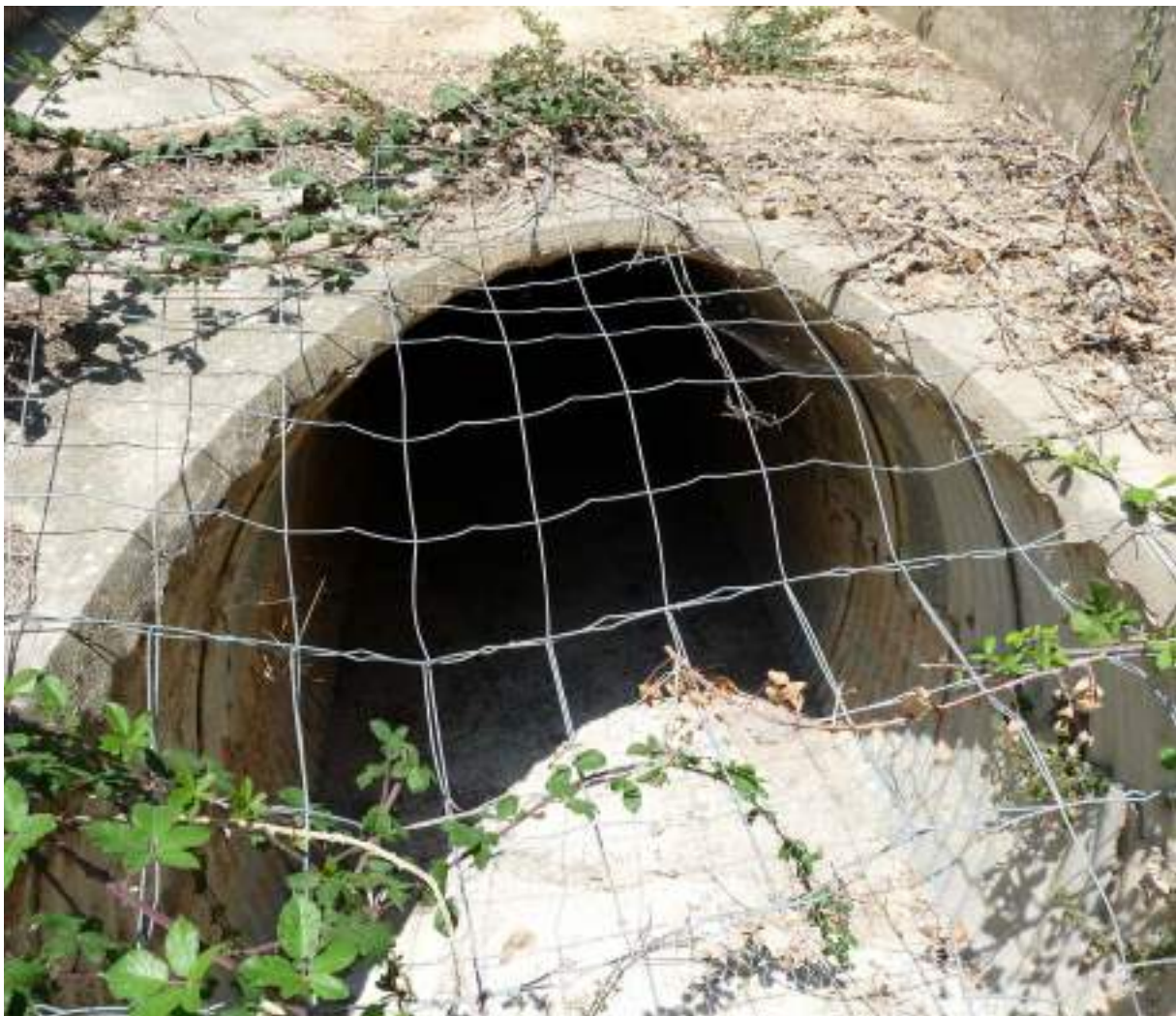
Busse parfaitement fonctionnelle pour la faune malheureusement condamnée par un grillage © Micaël GENDROT
