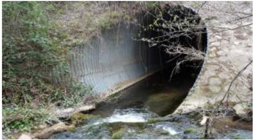
Passage du vallon de Fontlade sous l'autoroute © Micaël GENDROT
