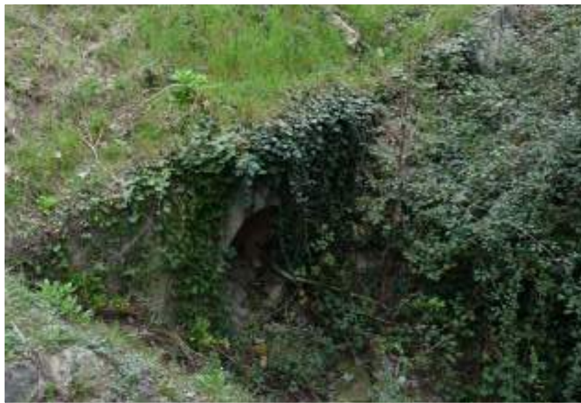
Buse de l'ouvrage n°18 © Micaël GENDROT
