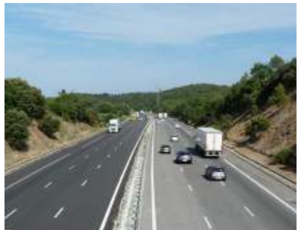
Autoroute A8 © Micaël GENDROT
