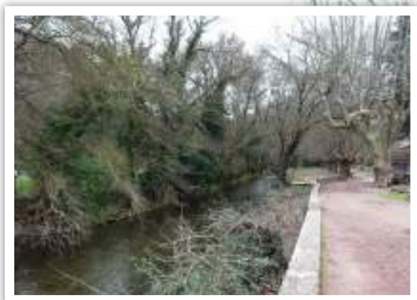
Berges verticales en amont du pont de la RD33 © Micaël GENDROT
