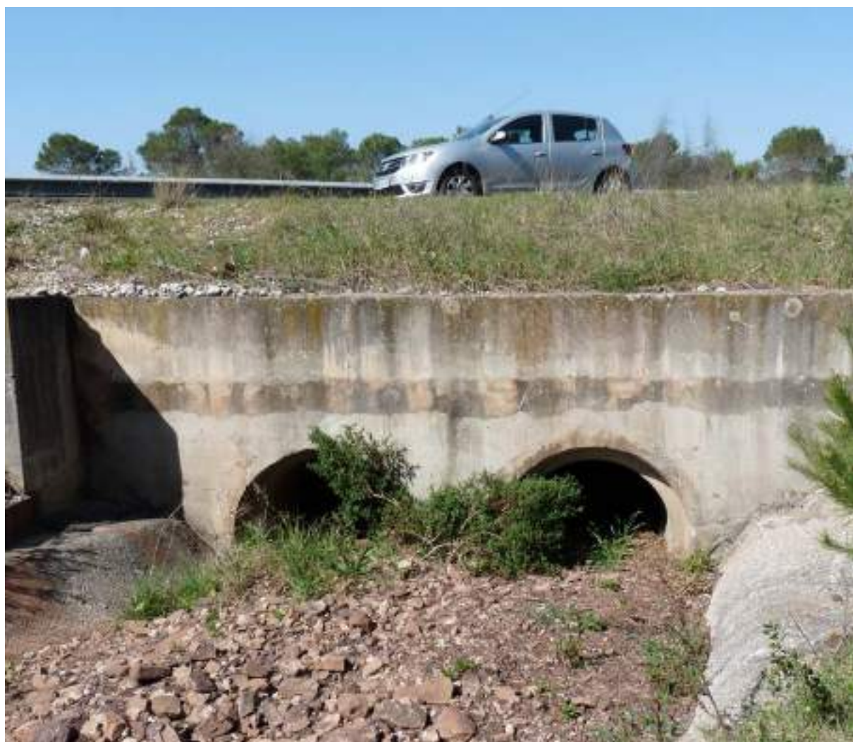
Buses ayant perdues un tiers de leur hauteur utile par engrèvement © Micaël GENDROT
