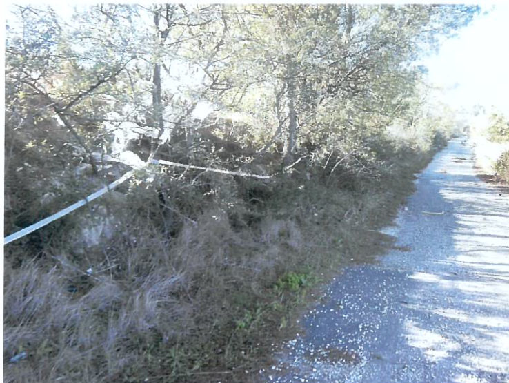
Photo 2 : remblai bordant le chemin
