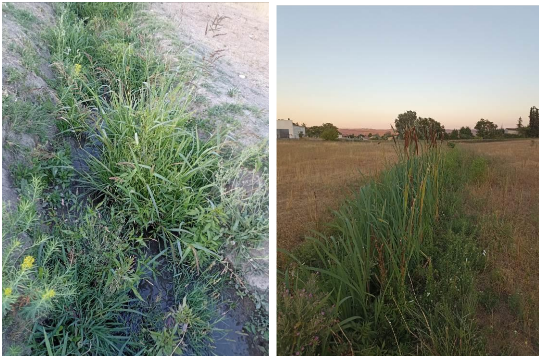
Figure 14 : Fossé de drainage
