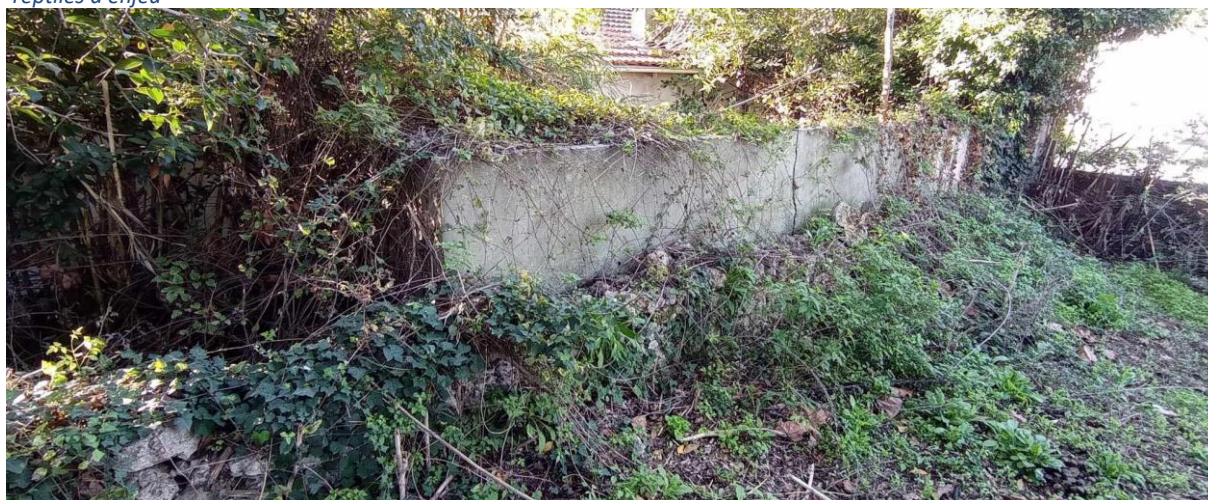
Muret en pierres en partie couvert de végétation favorables aux reptiles à enjeu
