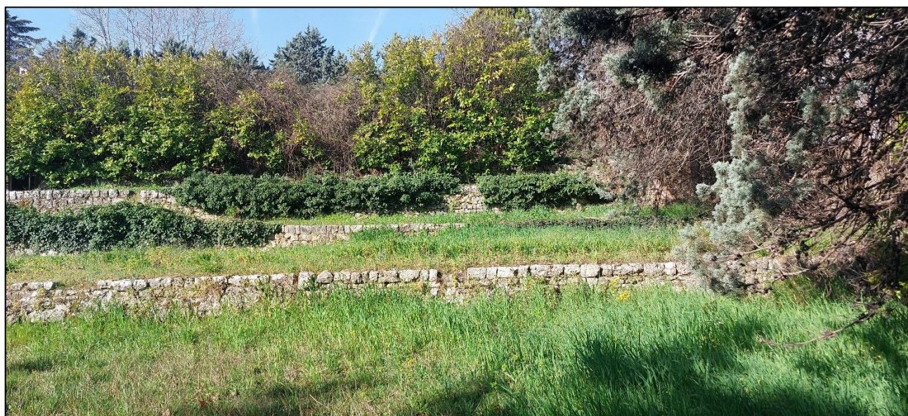
Présence de restanques sur site
