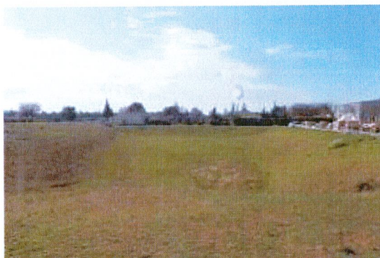
Photo 2 - Bassin de rétention [89.22 ; J5.41]
