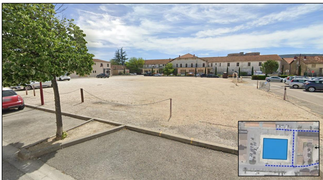
Illustration 3 : Place en stabilisé recouvrant l'ouvrage de rétention enterré (nord de la Route des Caves)
