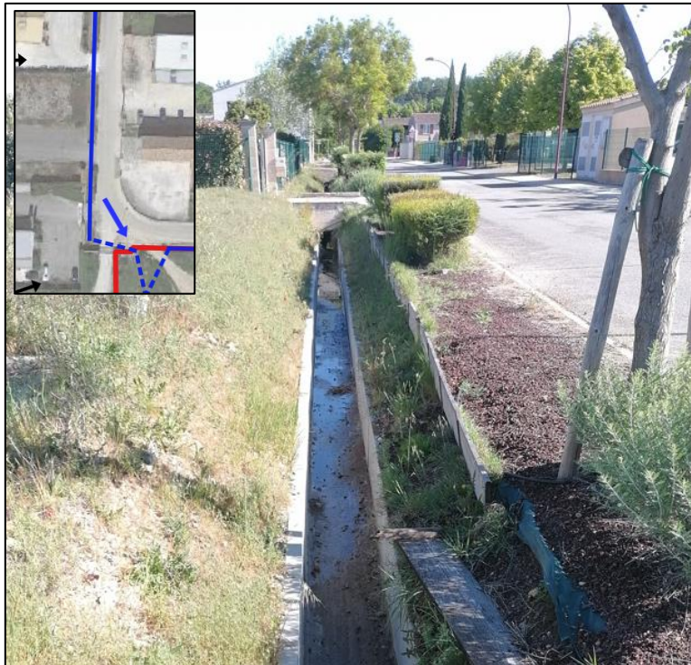
Illustration 5 : Canal bétonné le long de la rue du Grenache
