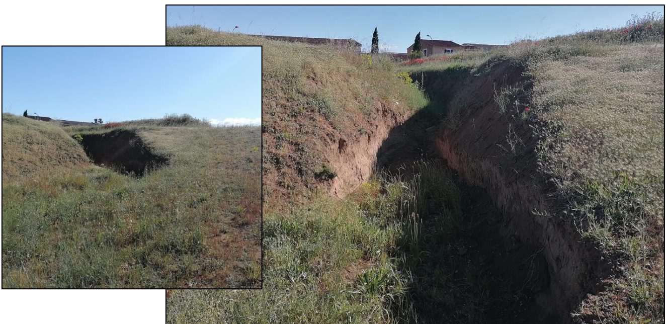
Illustration 8 : Fossé d'arrivée d'eau vers le bassin d'infiltration
