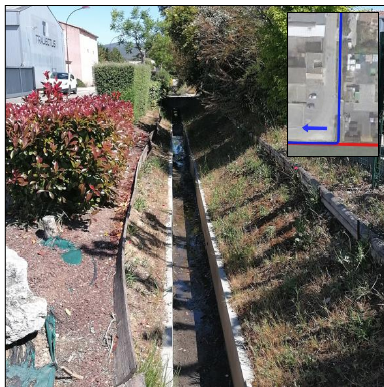
Illustration 6 : Canal bétonné le long de la rue de la Syrah
