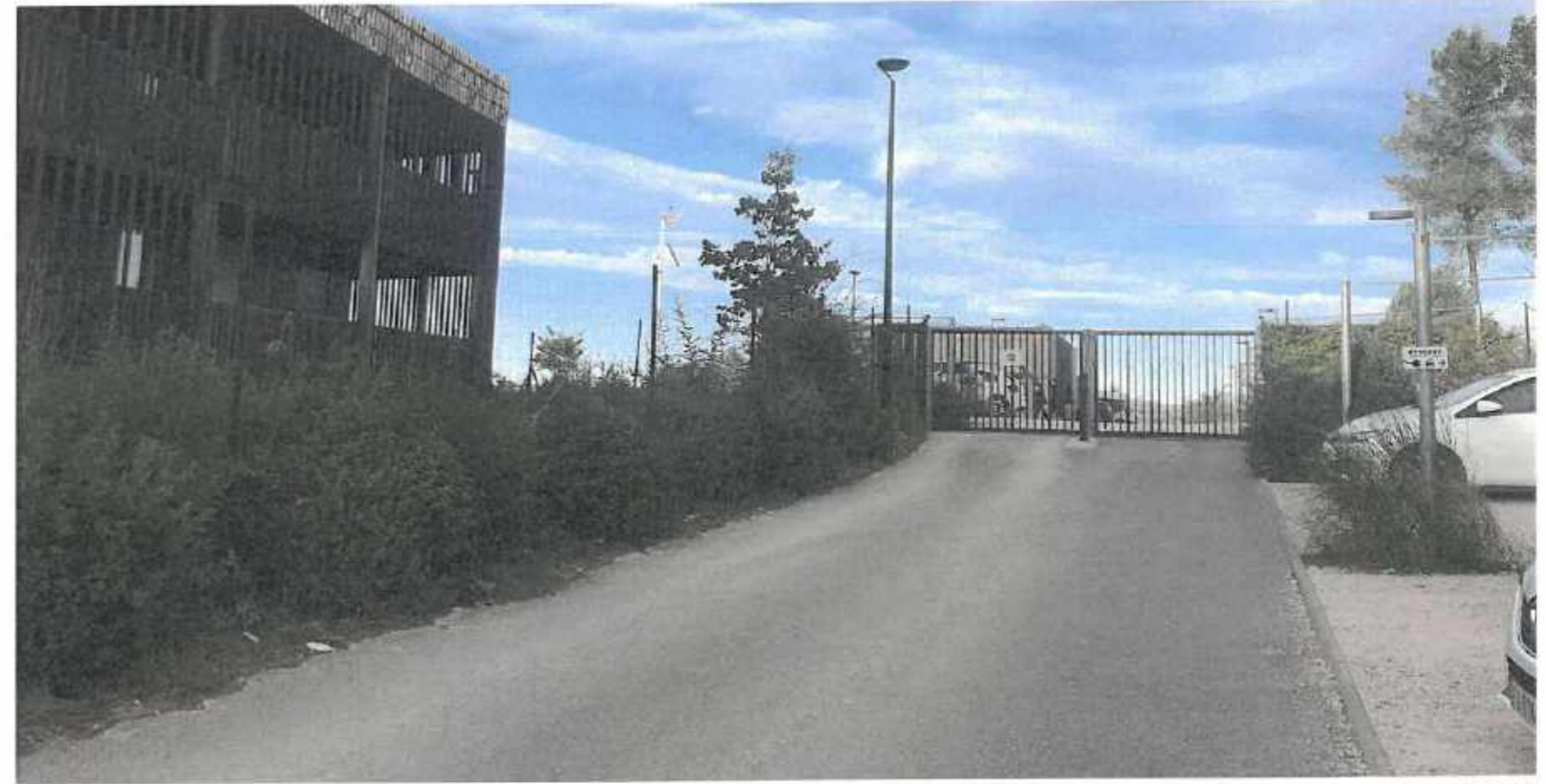
Point de vue 03 - Vue rapprochée (photographie - Septembre 2023)
