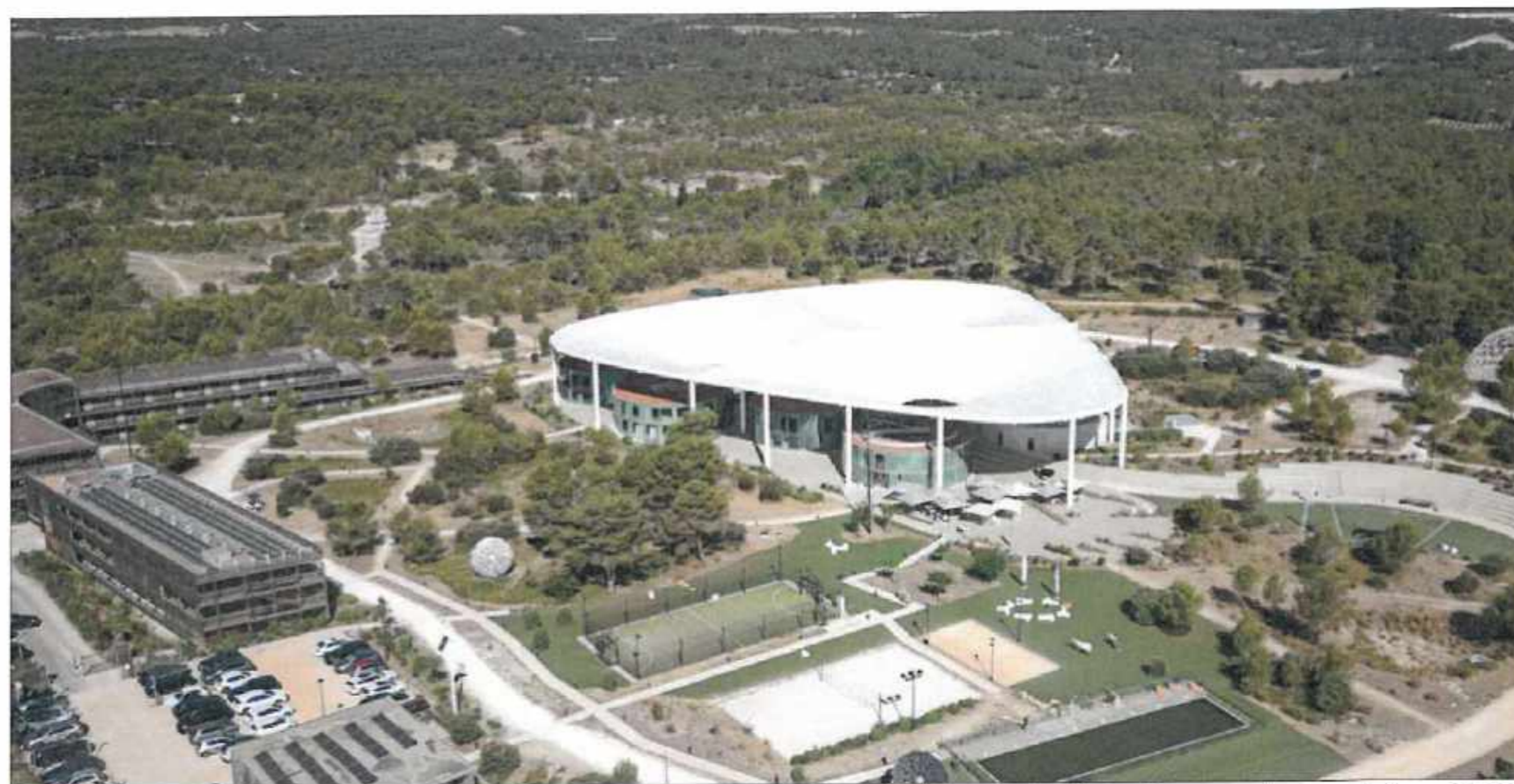
Point de vue 02 - Vue éloignée (photographie aérienne prise par drone - 2023)
