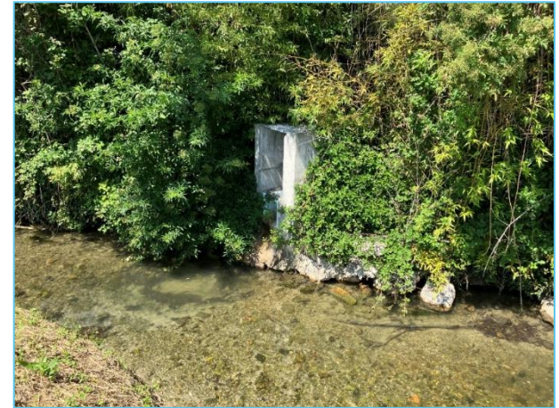
Point de rejet eaux de by-pass entrée
