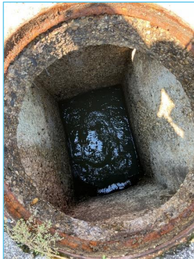
Regard entrée principale, amont débitmètre
