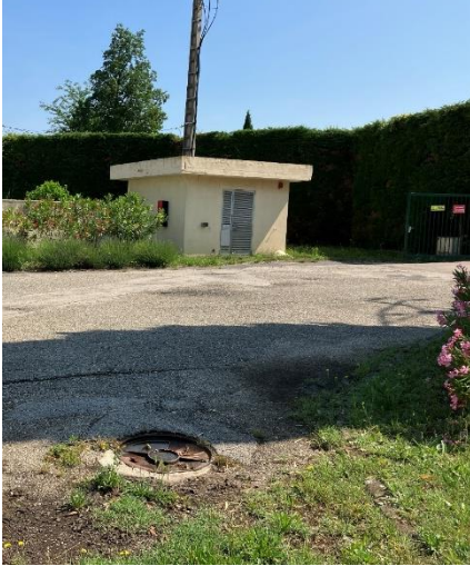
Regard entrée principale, amont débitmètre
