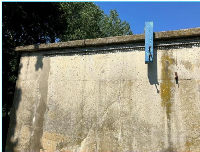
Épaufrures et fissures sur le BA2
