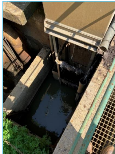
Dégrilleur automatique en amont du PR d'entrée
