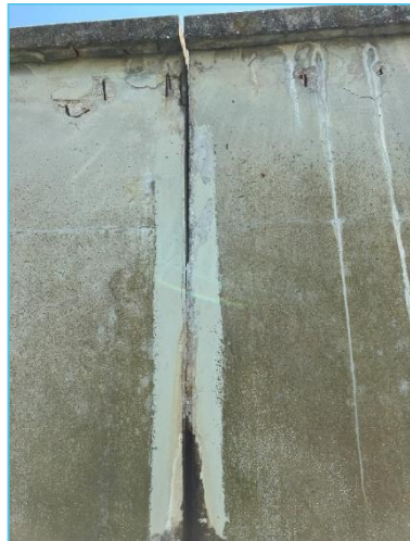
Aciers visibles et épaufrures BA2
