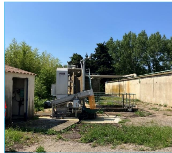
Dégrilleur automatique en amont du PR d'entrée
