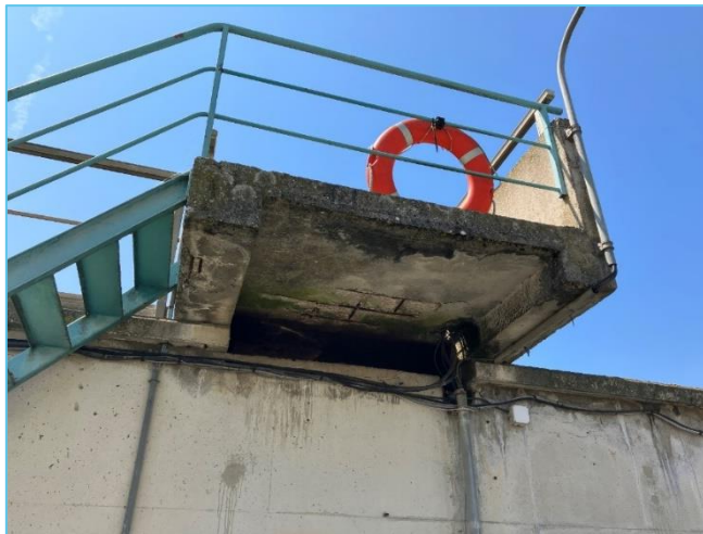
Escalier et passerelle d'accès au BA1 – aciers apparents – épaufrures
