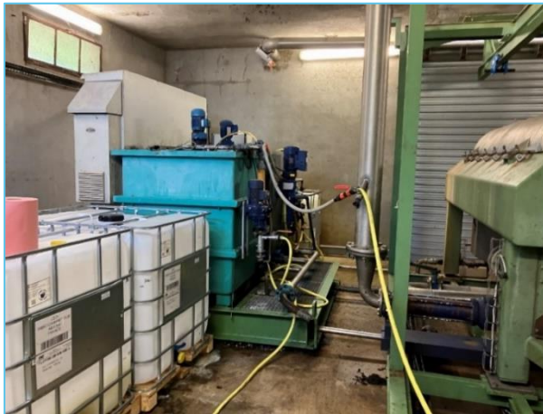
Préparateur polymère et stockage polymère
