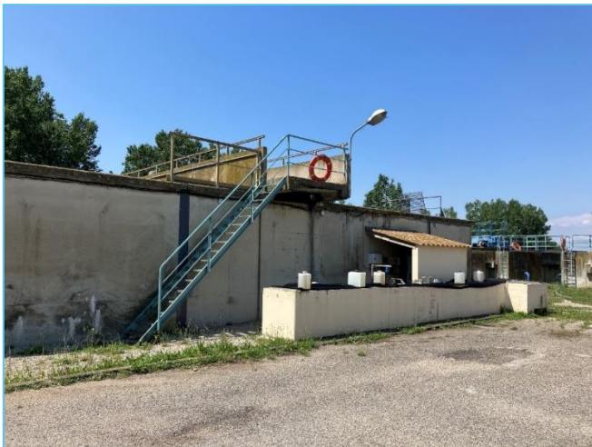
Escalier et passerelle d'accès au BA1 – aciers apparents – épaufrures
