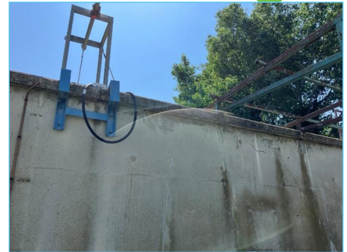
Épaufrures et fissures sur le BA2
