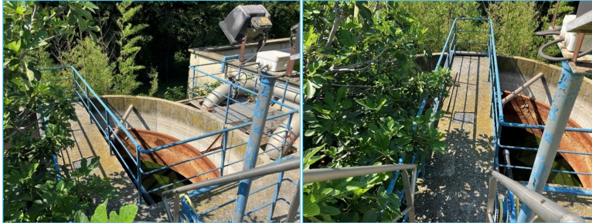
Dessableur-dégraisseur abandonné
