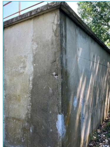
Aciers visibles et épaufrures BA2
