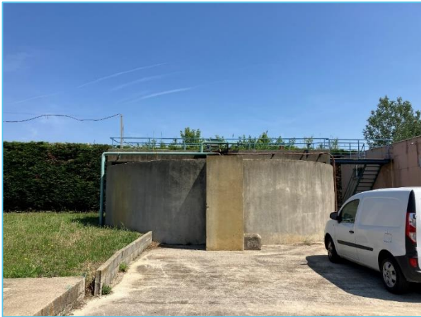
Silo à boues
