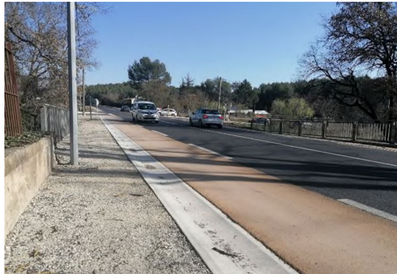
Figure 5 : Photo 2 - Cunette au Nord de la branche RD7n Ouest (03/2021)
