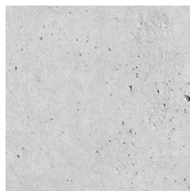
Panneaux en béton brut
