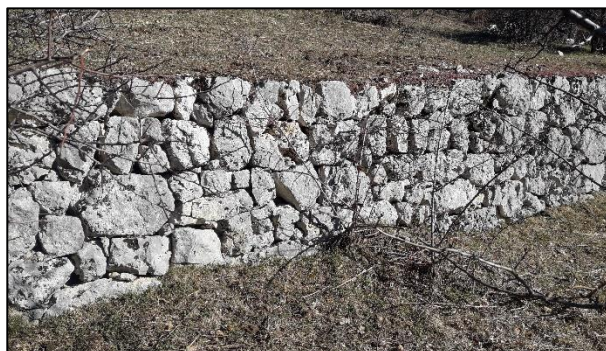
Exemple de muret en pierre favorable au gîte des reptiles et au Spélerpes de Strinati
