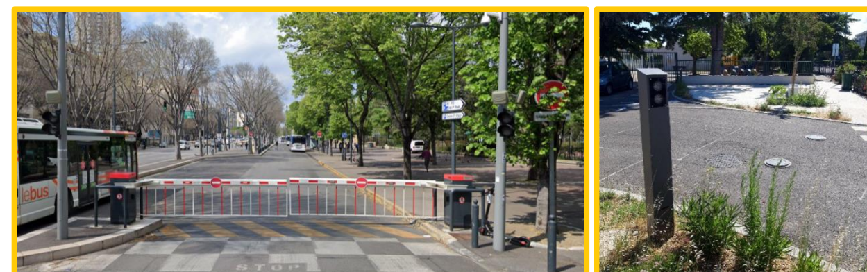
Exemple de contrôle d'accès
